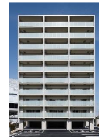
グランマスト萱場 (愛知県名古屋) 総戸数27戸 <2012年2月竣工>
