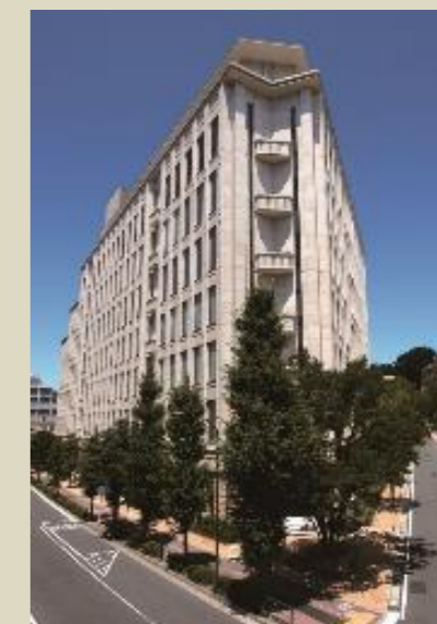
御殿山SHビル
