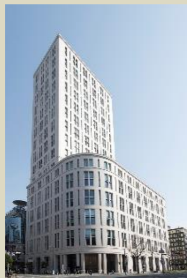
本町ガーデンシティ (オフィスビル部分)
