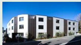
プライムメゾン 代官山 (東京都目黒区) 住戸数27戸 2017年1月竣工
