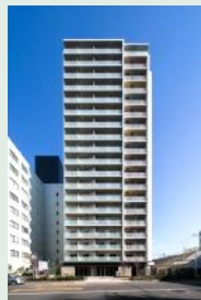
プライムメゾン 大塚 (東京都豊島区) 住戸数144戸 2017年1月竣工
