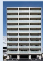
グランマスト 荻場 (愛知県名古屋市) 住戸数27戸 2012年2月竣工
