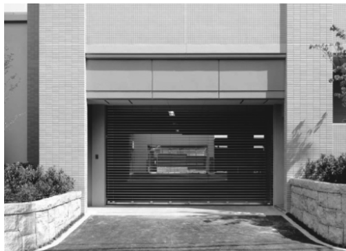
駐車場シャッターゲート (プライムメゾン高見)
