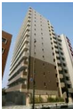
ジェイフラッツ 板橋区役所前
