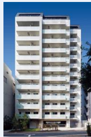
プライムメゾン 渋谷 (東京都渋谷区) 総戸数70戸 〈2014年7月竣工〉
