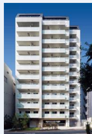
プライムメゾン 渋谷 (東京都渋谷区) 総戸数70戸 〈2014年7月竣工〉
