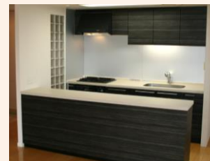
キッチン扉の貼替 (エスティメゾン恵比寿II)
